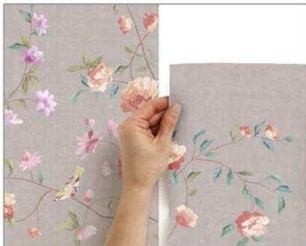
4. При монтаже панно, порезанного на рулоны. Последующее полотно клеится стык в стык к предыдущему, совмещая рисунок и фактуру.
