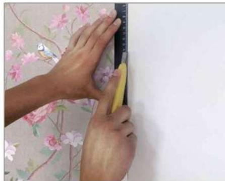
5. Край полотна подрежьте острым ножом по линейке или шпателю.
