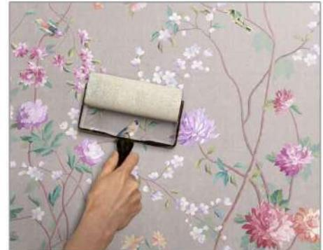
3. Складки и пузыри разгладьте валиком для обоев или обойным шпателем.
